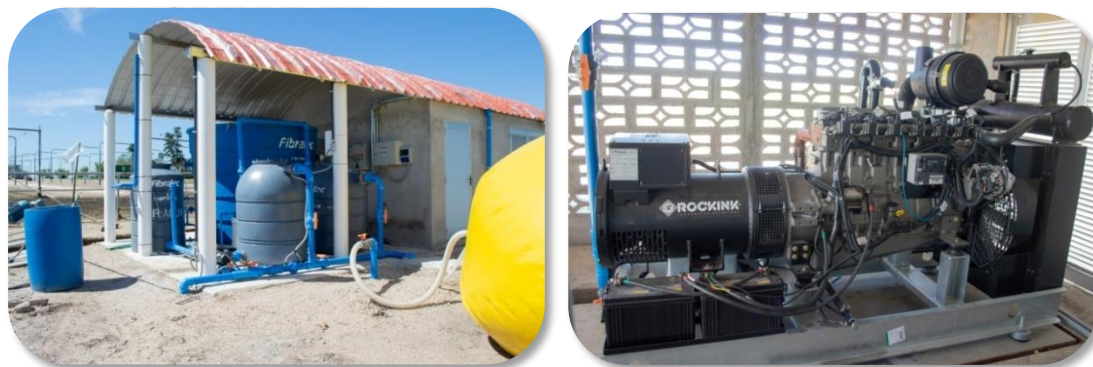
Figura 6. Sistema de purificación de biogás y motogenerador.
