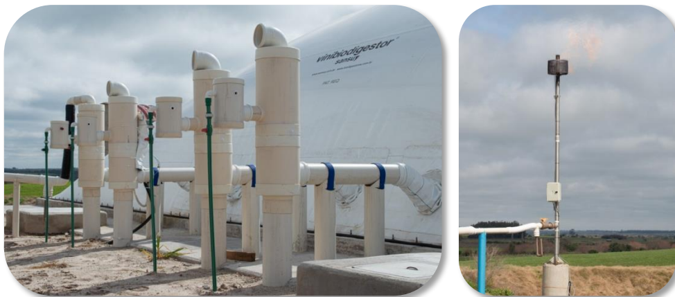
Figura 5. Válvulas de seguridad y antorcha.
